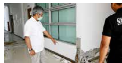
■ Pendirian tenda darurat dan pengecekan kondisi gedung.
