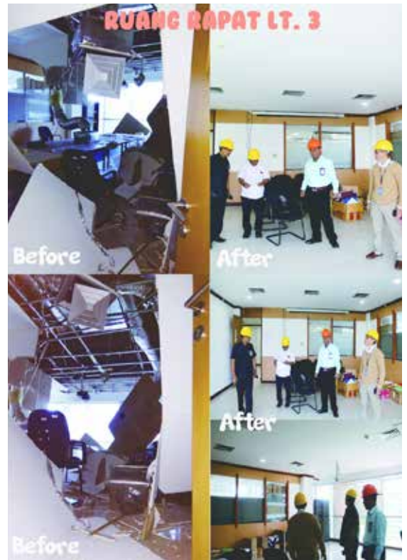
■ Kepala Perwakilan BPK NTB mengawasi renovasi gedung pasca gempa.
