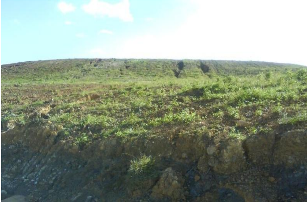
Gambar 20 : Penimbunan top soil pada PT Borneo Indobara yang belum dibuat sistem berjenjang/terasiring dan cover crop masih belum merata
